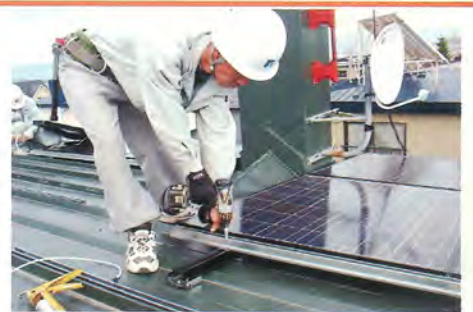
( 太 陽 電 池 パ ネ ル 取 付 )
