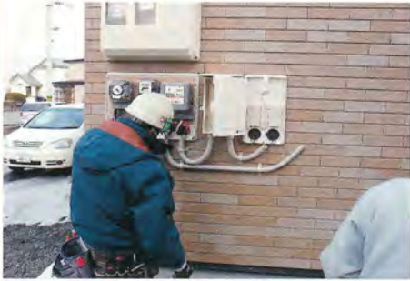
( メ ー タ ー 廻 り 切 替 工 事 )
