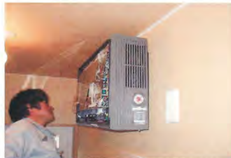
( イ ン バ ー タ 取 付 ・ 配 線 工 事 )
