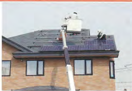
( 屋 根 架 台 取 付 )
